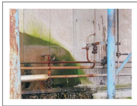
Imaxe dunha fuga de auga quente.
