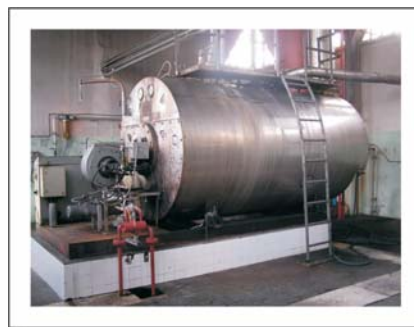
Imaxe dunha caldeira de fuel nunha industria cárnica.
