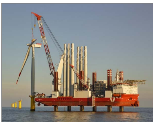
Figura 4: Instalación de turbina offshore. Fuente: E.ON
