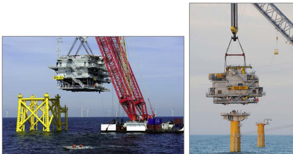
Figura 31: Montaje de subestación offshore sobre su cimentación (Derecha): monopilote, (Izquierda) jacket. Fuente: www.offshore-energy.co
