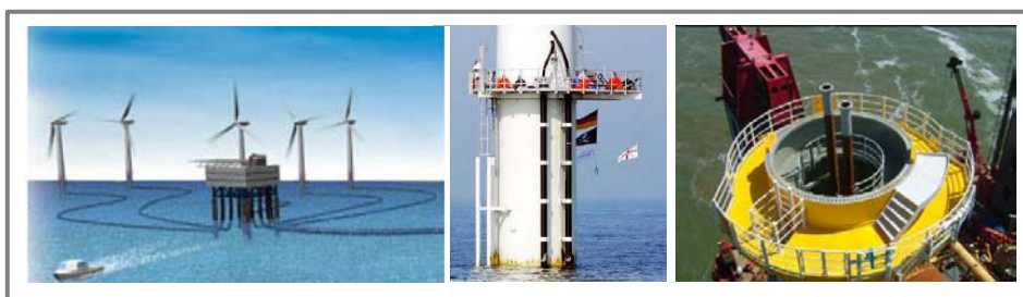
Figura 25: Salidas del cable de MT de los aerogeneradores. Fuente: Esteban Pérez, M. D., 2009
