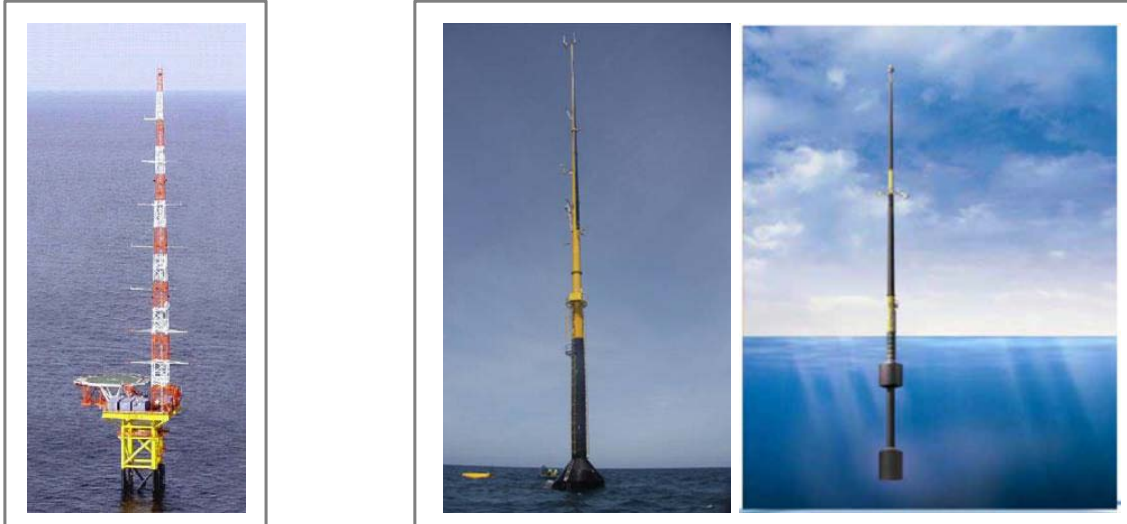
Figura 10: (Izq.) Torre meteorológica FINO 1 en el mar del Norte. (Der.) Torre meteorológica IDERMAR. Fuente: RWE, proyecto IDERMAR
