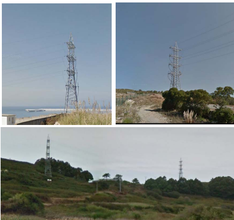
Ilustración 23: Imágenes de los pasos aéreo/subterráneo de las líneas de 66kV en el entorno del Puerto Exterior
