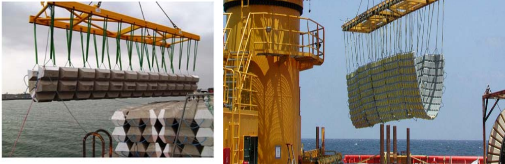
Ilustración 39: Manta de protección de hormigón [Subsea Protection Systems & Pipeshield®]
