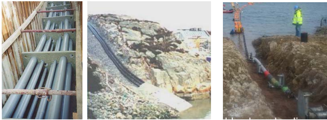
Ilustración 37: Ejemplos de paso terrestre/submarino de los cables [1]
