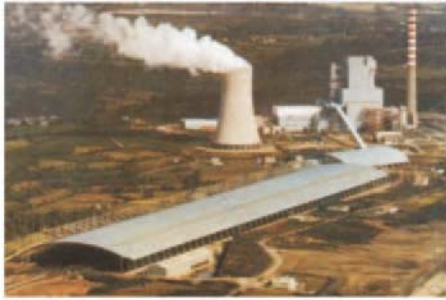
Central térmica convencional
