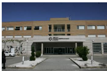
Hospital de Verín
