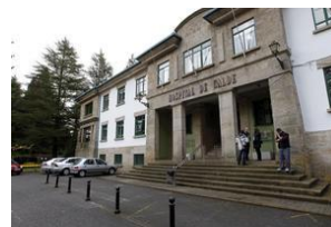
Hospital de Calde
